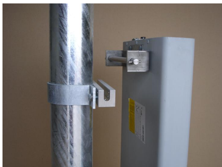
4 - Décrochage partie haute de l'antenne
