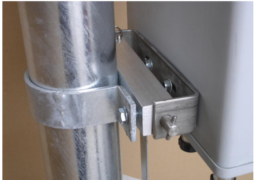
Détail fixation basse de l'antenne
